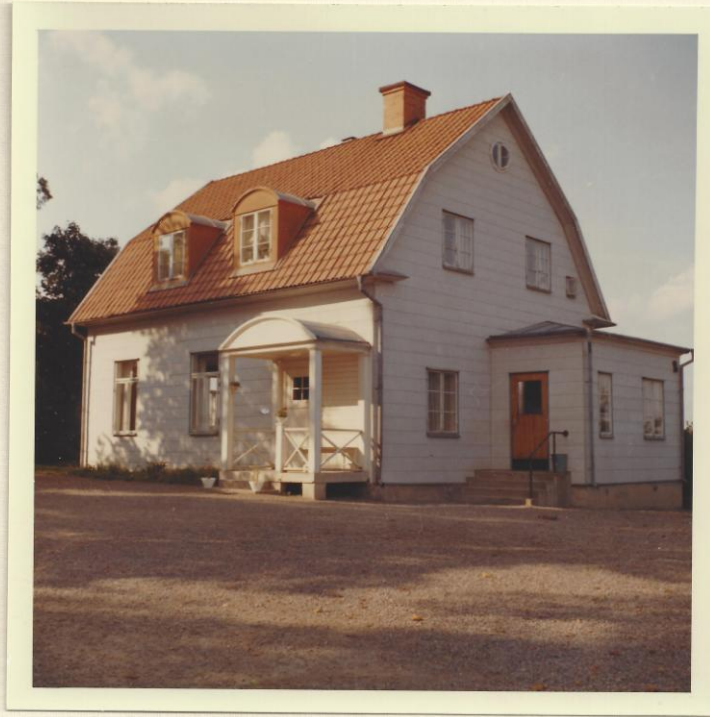
Kuddby. Lilla skolan. Renoverad 1953.
