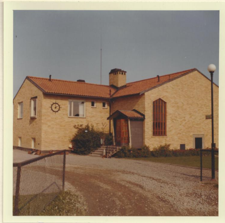
Kuddby skola. Uppförd 1953.
