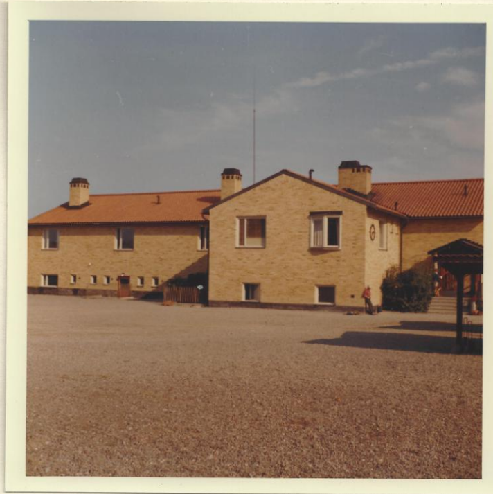
Kuddby skola. Uppförd 1953.
