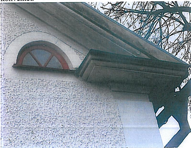
Lunettfönster och takfot
